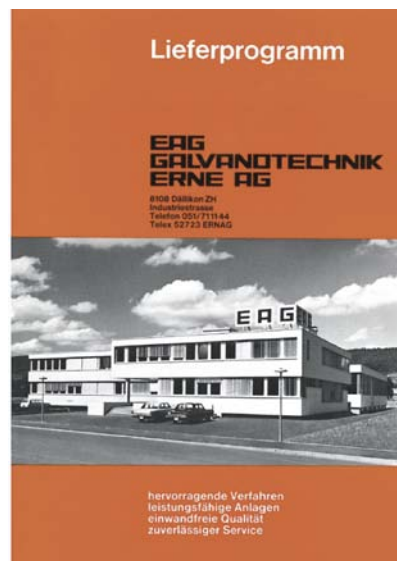
Ende der Sechzigerjahre: Werbung mit dem hochmodernen Industriegebäude.
