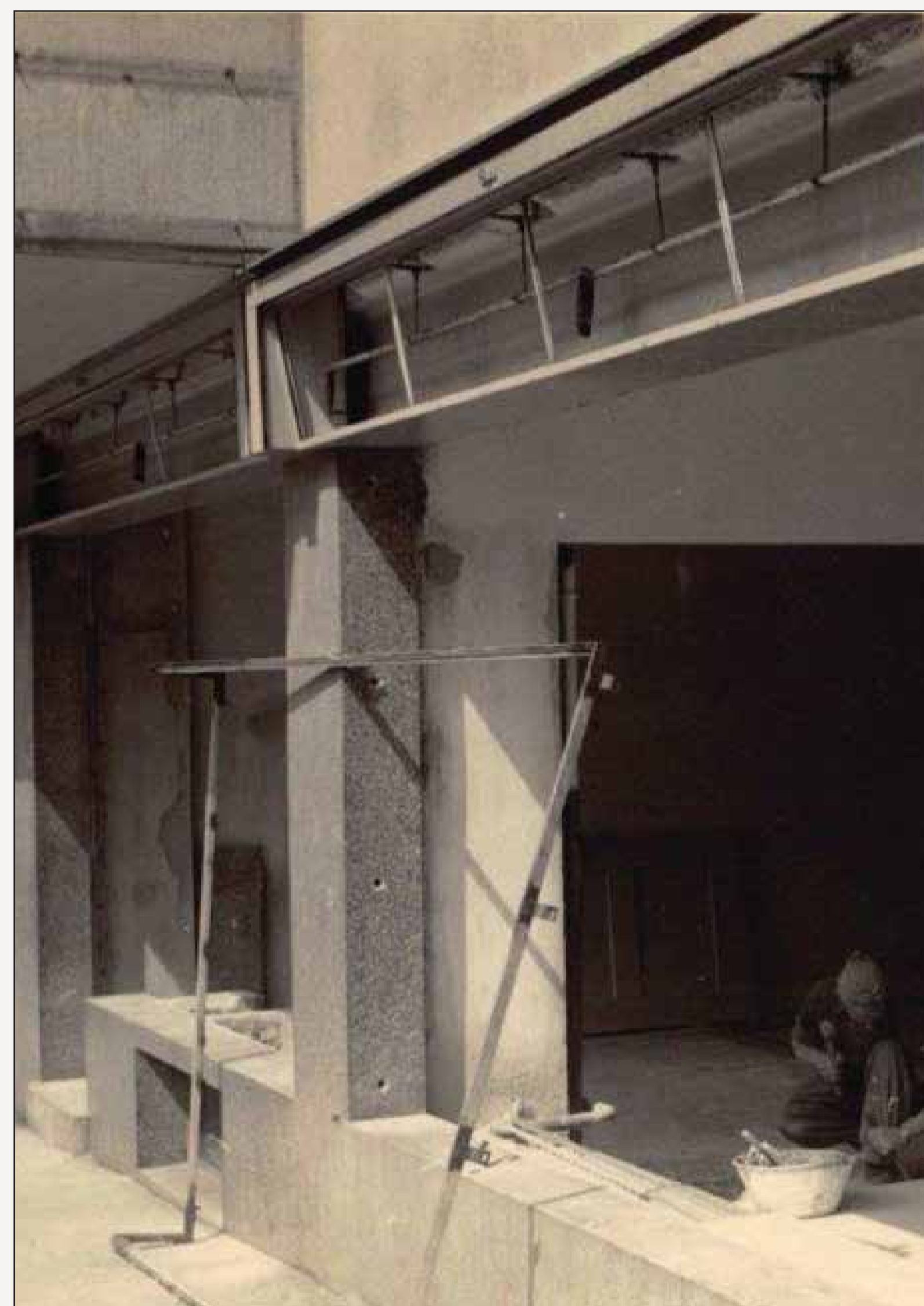
Das Lokal für die Drogerie ERNE und F. ERNE Galvanobedarf-Metallchemie wird hergerichtet (1936)
