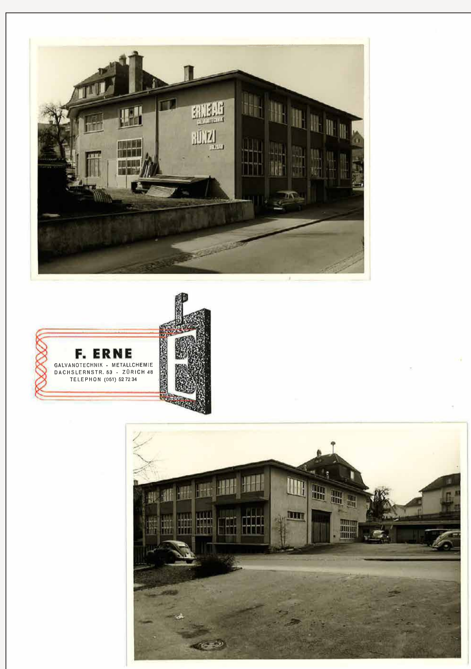
Gemietetes Lokal in Altstetten, Dachslerenstr. 63
