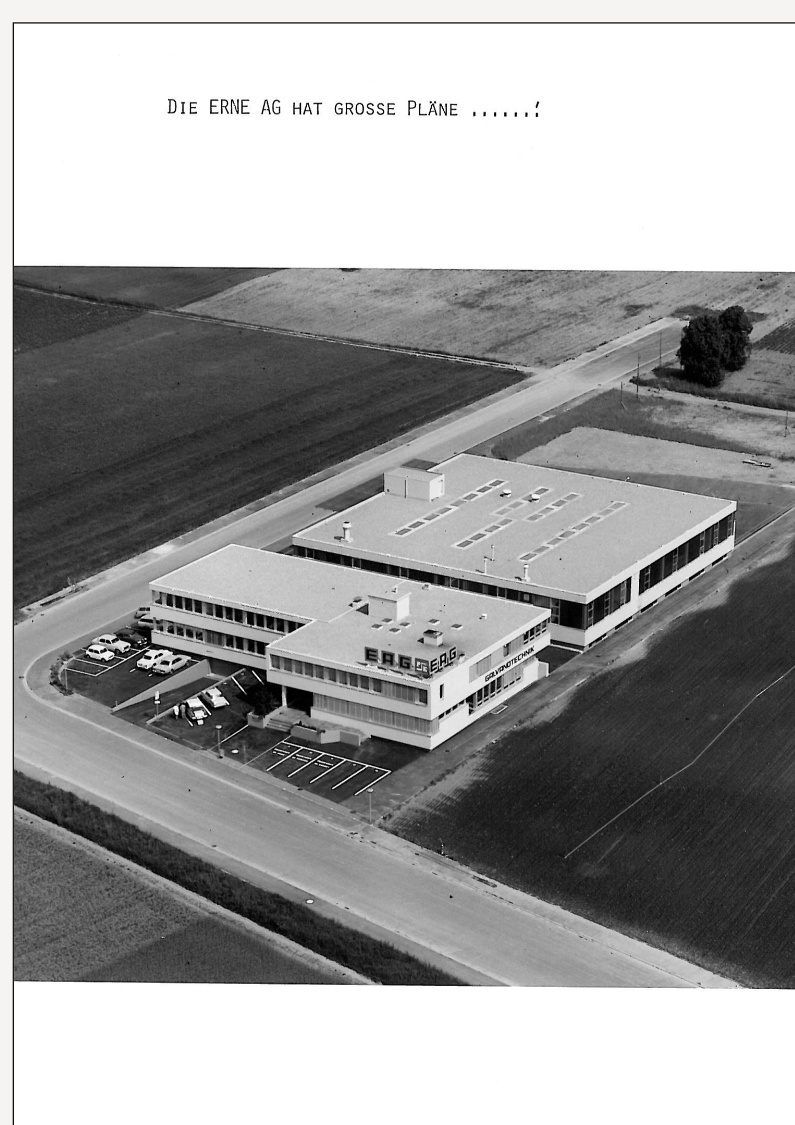
Das Gebäude von oben: das 1. Gebäude an der neu erstellten Industriestrasse und der Lindenstrasse
