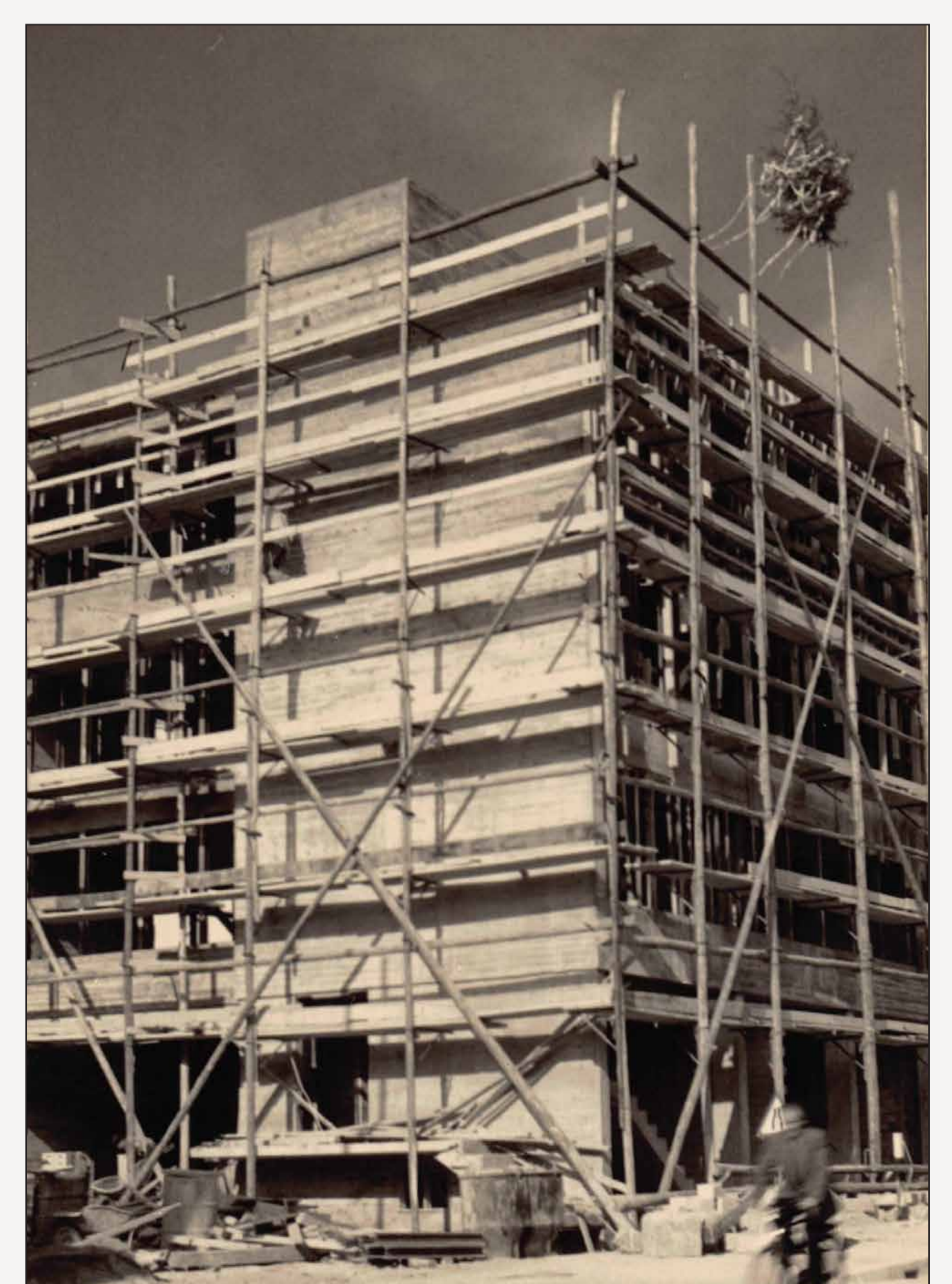
Baustelle für eigenes Gebäude Dachslerenstr. 63
